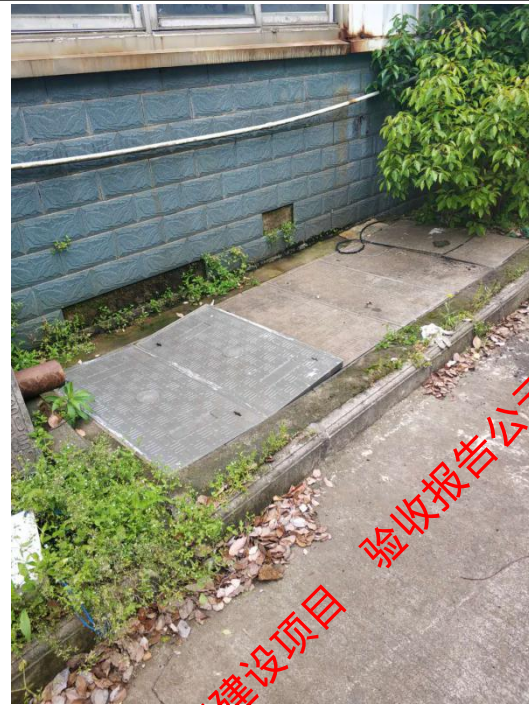
厂区自建沉淀池
