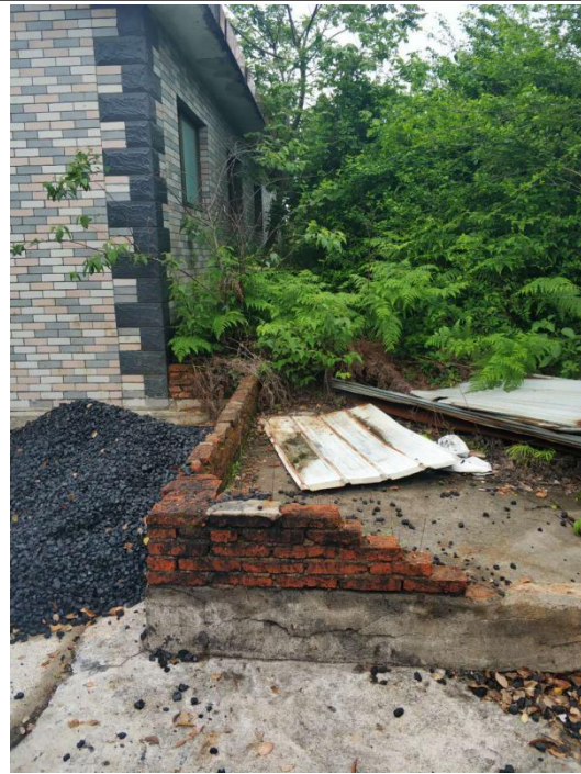
厂区自建化粪池
