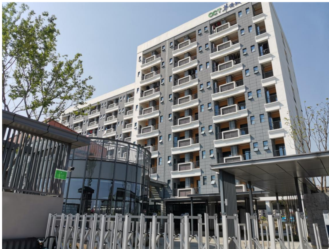
主体工程区（2020年5月）
